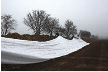
włóknina (szer. 4,9 m) rozkładana na długość z każdej strony przymy
